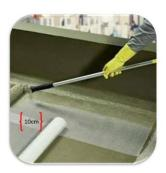
Na segunda demão usar 0,65 kg/m² de consumo, cobrindo toda a tela com a membrana de PU.
