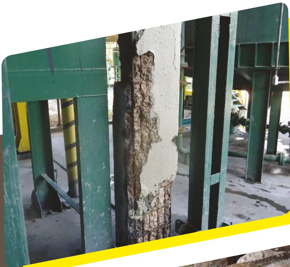
Deslocamentos de concreto e armadura exposta devido à corrosão de armaduras em edifício industrial (fonte: Carmona Soluções de Engenharia).
