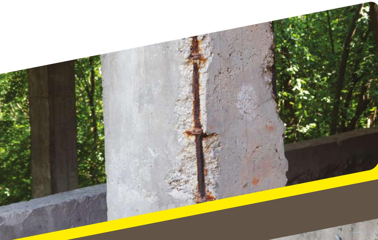
Deslocamentos de concreto ocasionados por corrosão de armaduras em um pilar de garagem.
