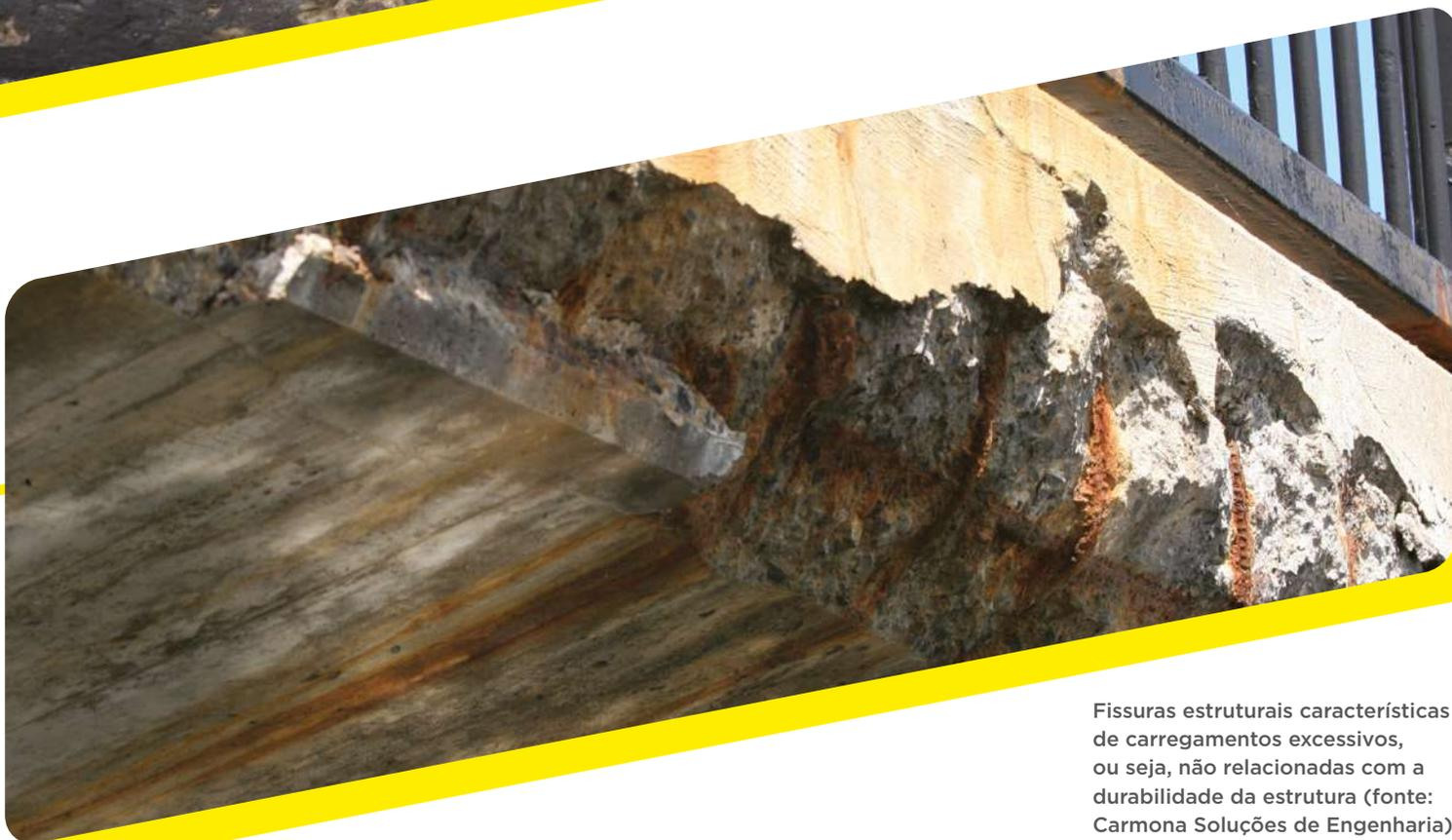
Fissuras estruturais características de carregamentos excessivos, ou seja, não relacionadas com a durabilidade da estrutura (fonte: Carmona Soluções de Engenharia).
