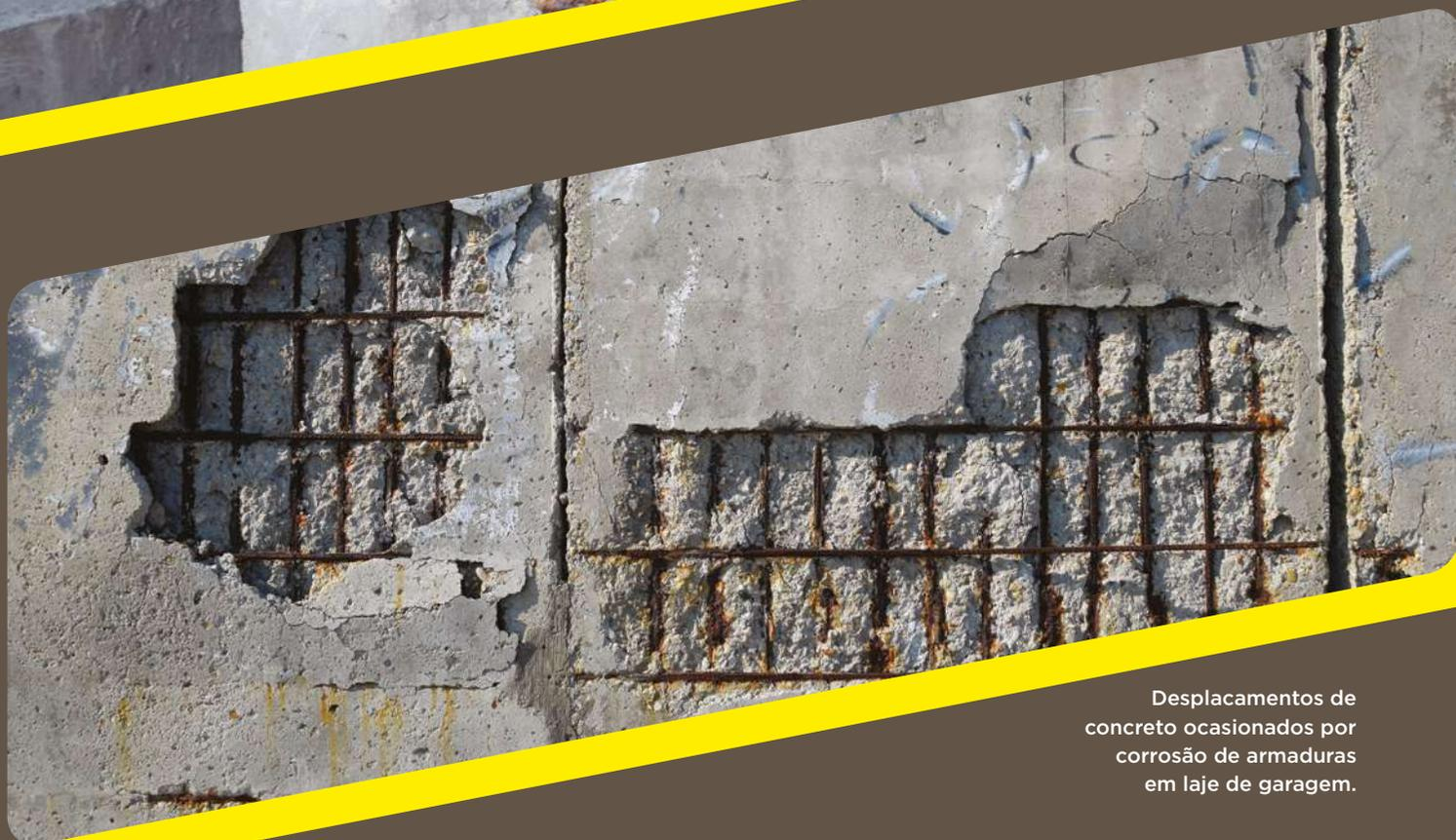
Deslocamentos de concreto ocasionados por corrosão de armaduras em laje de garagem.
