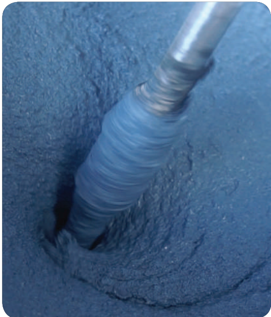
3. Mistura mecânica do produto antirruído quartzolit
