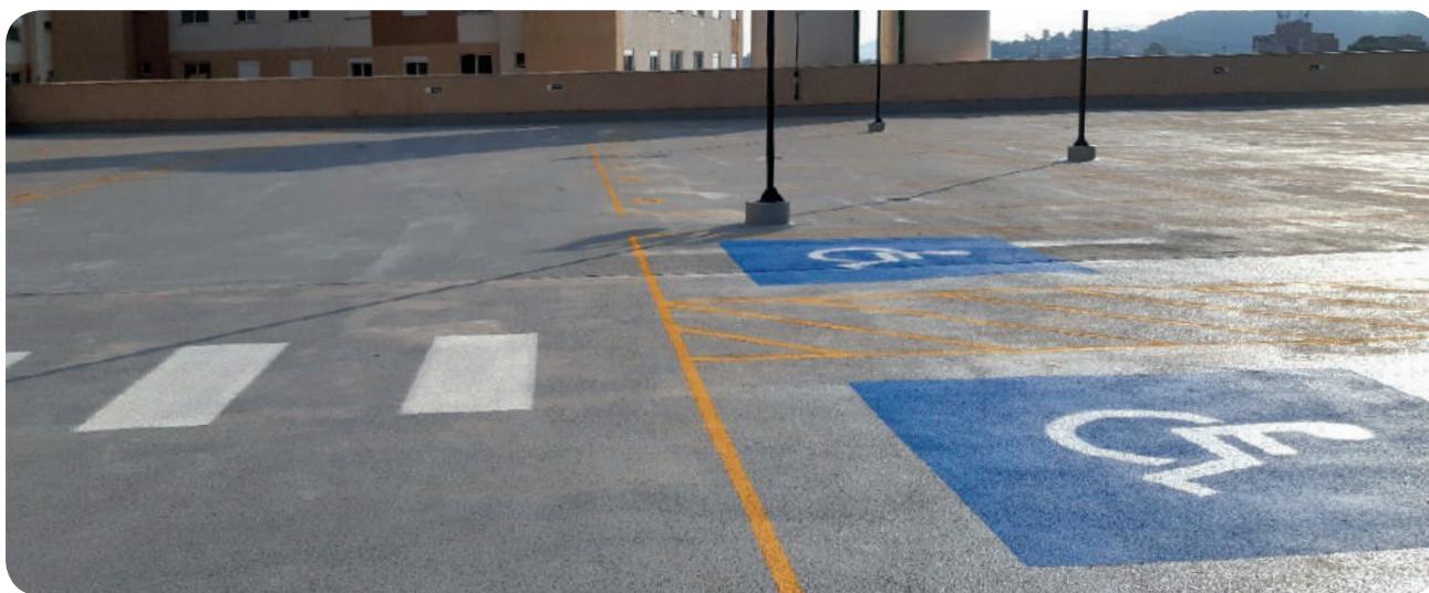
Aplicada da camada de proteção final Weber.dry pur coat traffic
