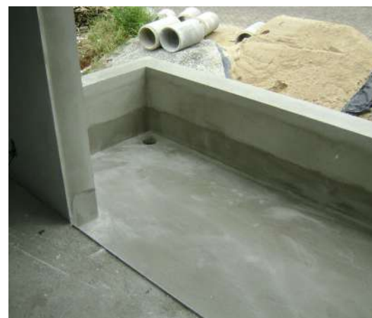
Sacada em balanço impermeabilizada com tecplus flex quartzolit.
