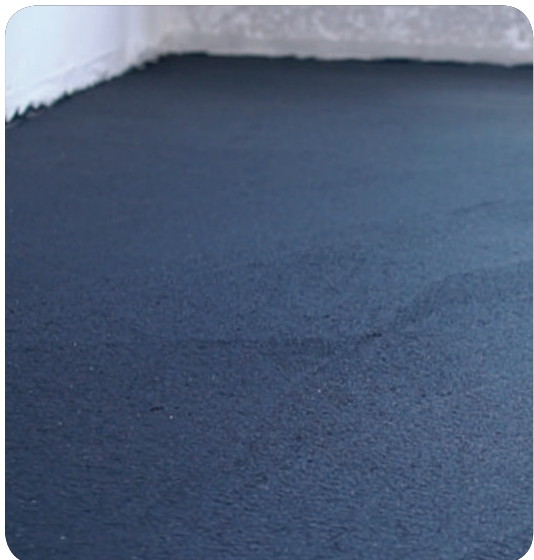
6. Antirruído quartzolit executado.
