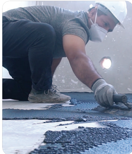
5. Aplicação do Antirruído quartzolit.
