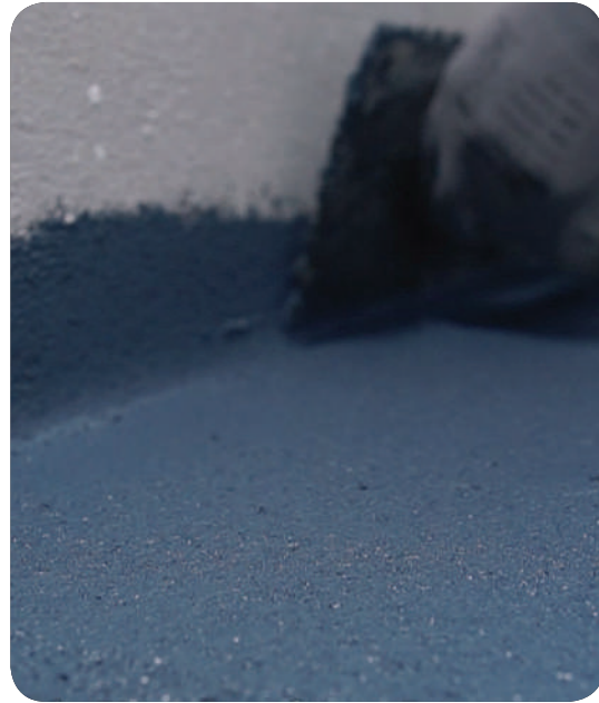
4. Faça rodapé de aproximadamente 5 cm.
