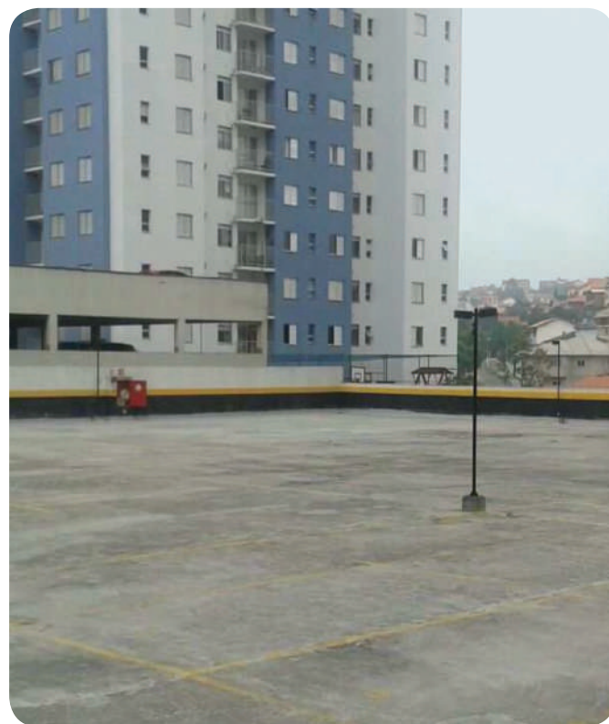
Lixamento mecanizado com politriz dotada de pedra 60.
