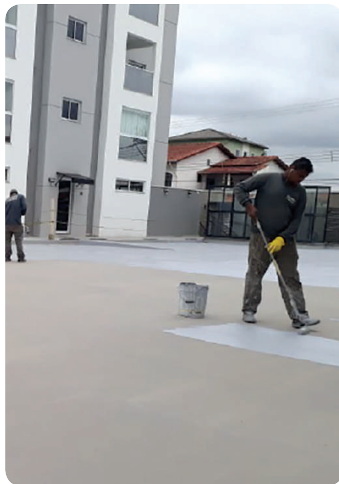
Substrato devidamente tratado e aplicação do primer - weber.guard pur primer 710
