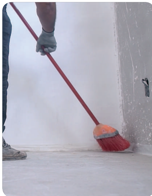
1. Raspagem e limpeza.
