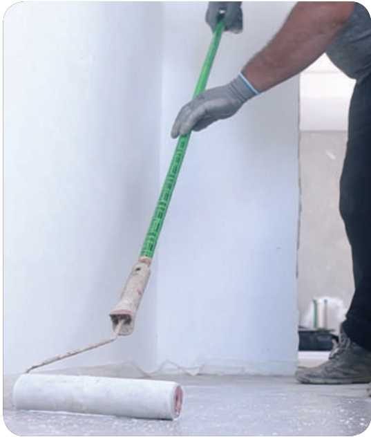
2. Aplicação do Primer Base quartzolit.
