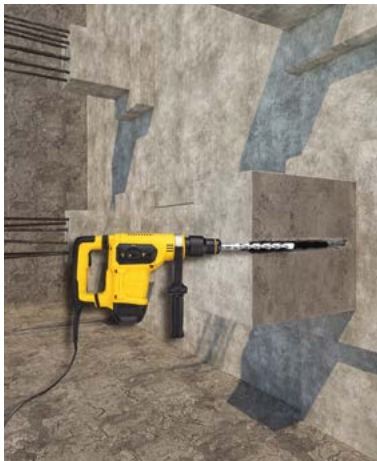
1 Execução do furo
