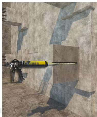
3 Preenchimento do furo
