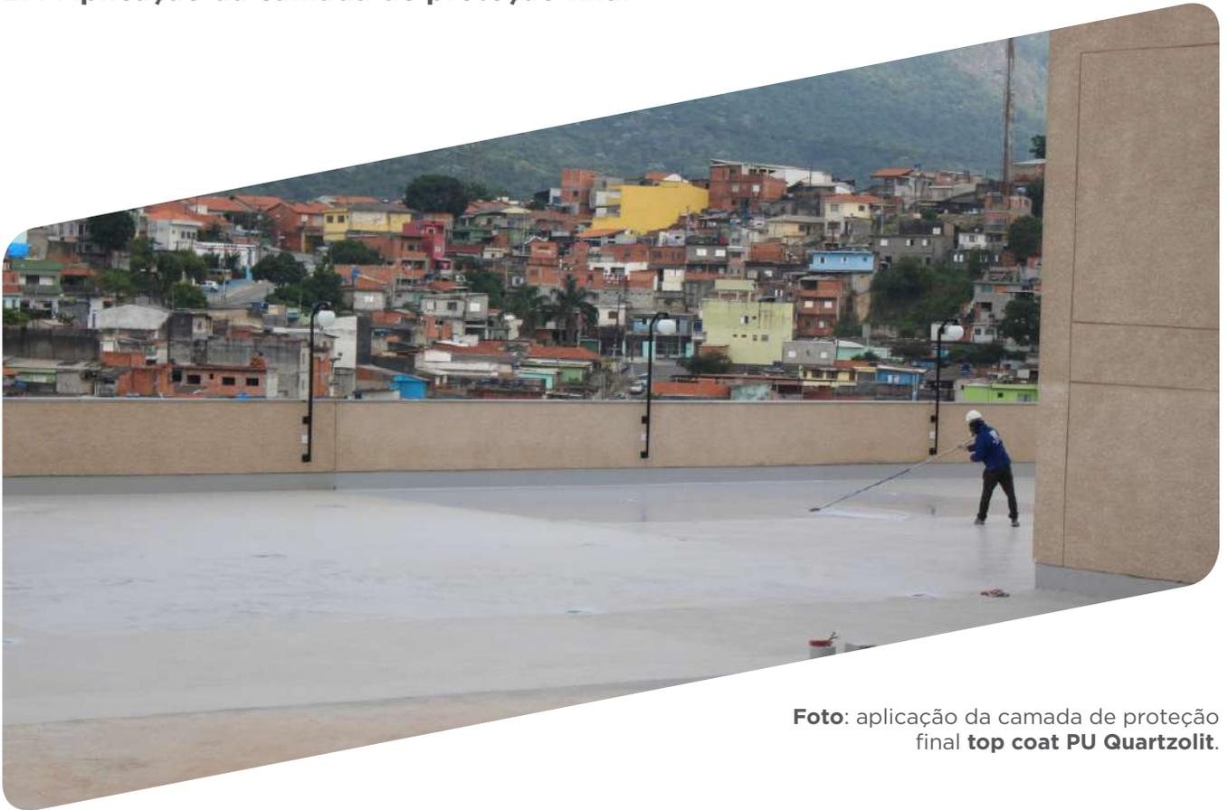
**Foto:** aplicação da camada de proteção final **top coat PU Quartzolit**.
